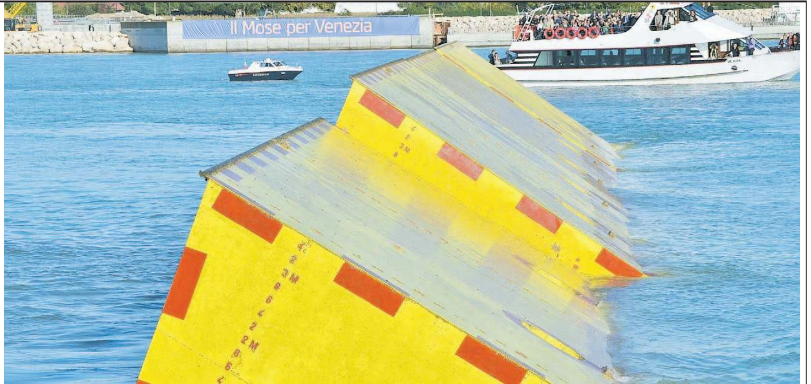
▲ Al Lido Le dighe mobili del Mose alla bocca di porto del Lido
