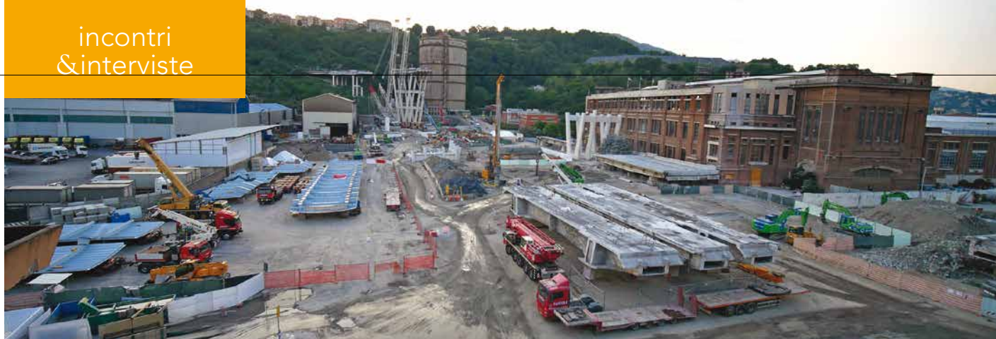
16. Una panoramica del cantiere dove sono visibili a sinistra le nuove strutture dell'impalcato e, a destra, le travi demolite
