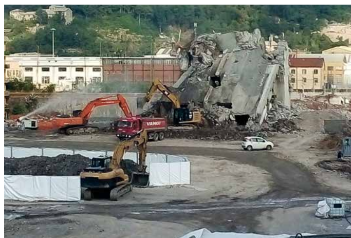
9. Confinamento del terreno di scavo anche con presenza di idrocarburi smaltiti secondo modalità di Legge
