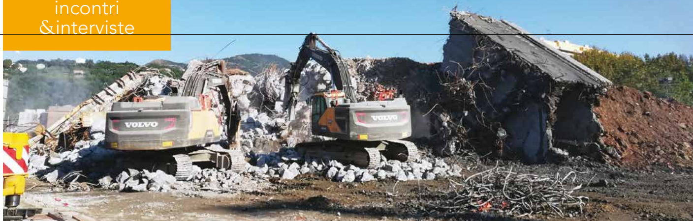
5. La demolizione e smaltimento dei calcestruzzi e materiali ferrosi
