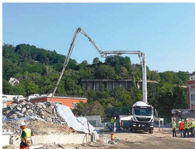
13. La realizzazione di una delle 18 stazioni di fondazione con pompa calcestruzzo. Lavorazione contemporanea alla demolizione delle macerie
