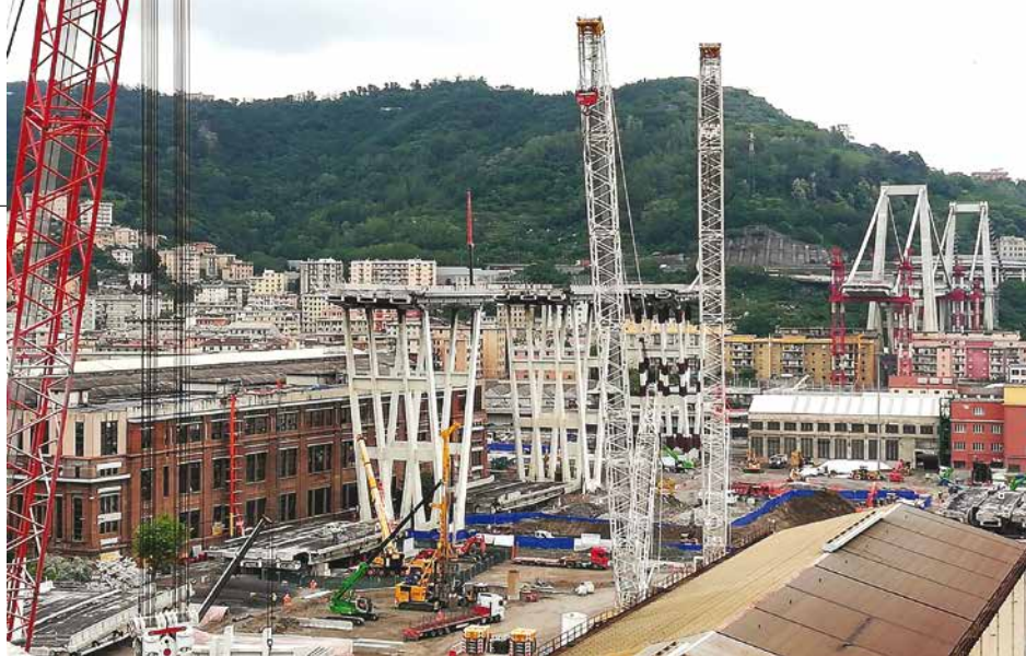
2. L'inizio dello smontaggio delle pile lato Ovest del viadotto Polcevera (21 Maggio 2019)
