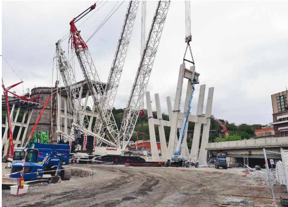
7. Lo smontaggio delle pile lato Ovest
