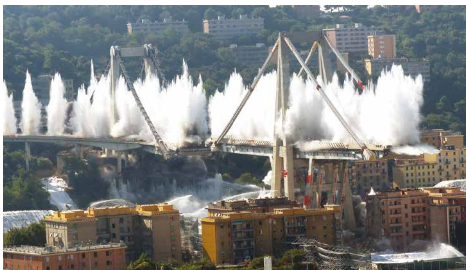
4. La demolizione con esplosivo delle pile 10 e 11 lato Levante (28 Giugno 2019)
