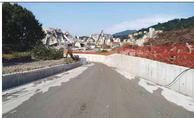
12. Una strada di accesso al cantiere
