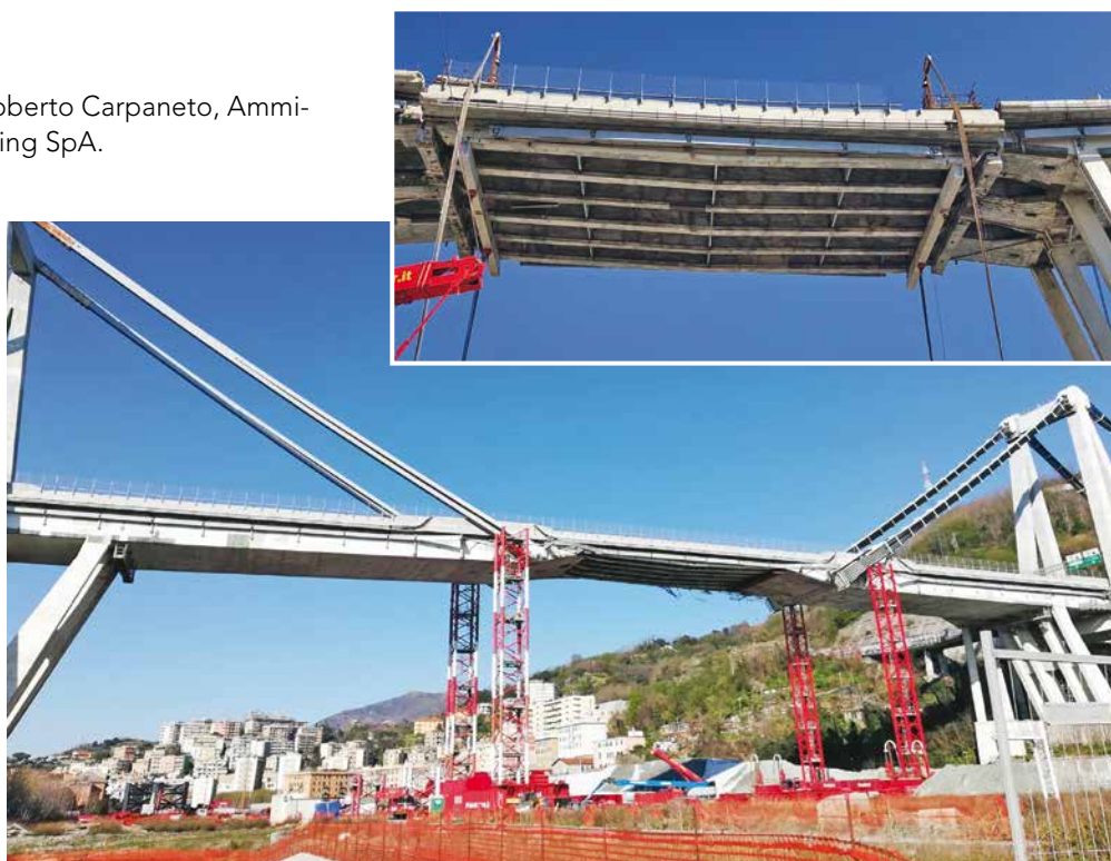
3A e 3B. Lo smontaggio della trave tampone tra le pile 10 e 11 (Maggio 2019)
