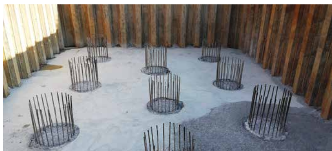
10. Le palificazioni per il consolidamento della fondazione base plinto. Ad oggi sono stati realizzati 10 km di pali
