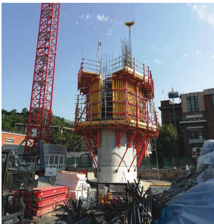
11. La prima pila in fase di getto
