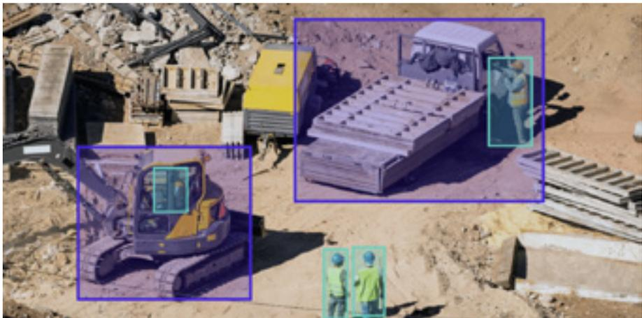
*Immagine che rappresenta il riconoscimento automatico di mezzi e persone in cantiere tramite sistemi di visione e algoritmi di intelligenza artificiale.*
