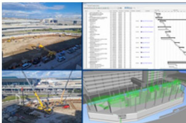
*Il cantiere viene gestito interamente sulla piattaforma CDE con un aggiornamento costante del modello 4D e rilasci progressivi di modelli costruttivi che vengono validati dalla DL.*
