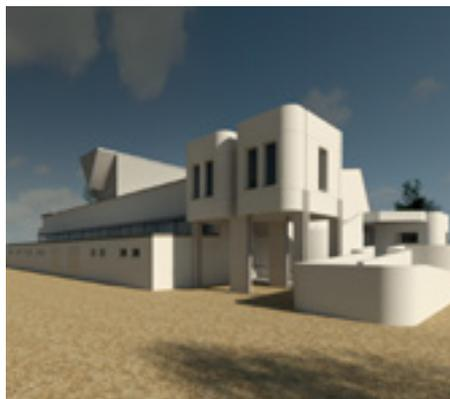
*Vista 3D lato ingresso. Realizzazione del nuovo blocco spogliatoi e centrale termica con copertura in pannello lamiera sandwich. Ampliamento della palestra con nuovi blocchi tipo Ytong.*
