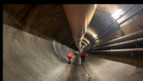
ASSISTENZA AMBIENTALE DI CANTIERE
