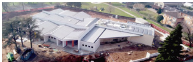
Fig. 2 Due viste a drone del cantiere della Scuola dell'infanzia di Rezzato (stato di avanzamento febbraio-marzo 2025)
