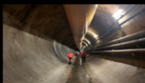
ASSISTENZA AMBIENTALE DI CANTIERE
