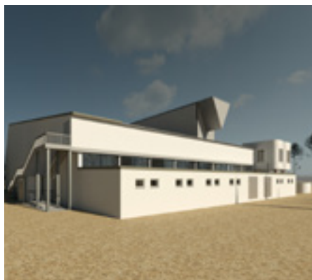
Vista 3D lato scala di emergenza. Realizzazione della nuova rampa di accesso al blocco spogliatoi per persone diversamente abili. Realizzazione di una nuova scala di emergenza metallica.
