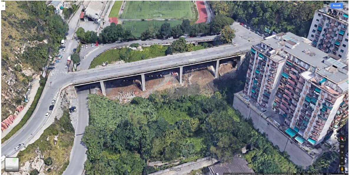
Figura 1: Vista 3D del Ponte Don Acciai estratta da google maps
