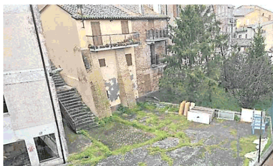
Il cantiere alla ex Bruno da Osimo
