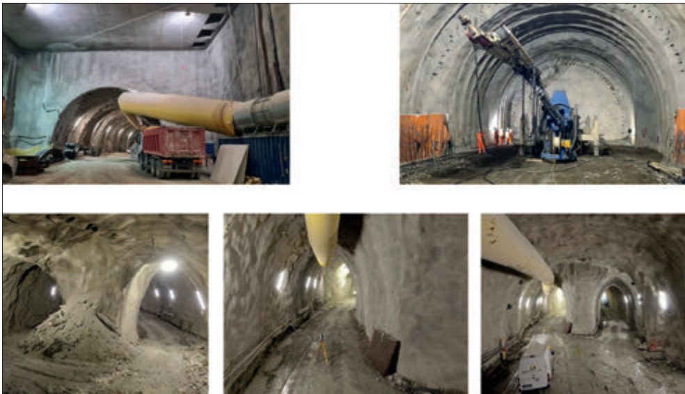
Fig 5 – Galleria naturale – Fotodocumentazione dei lavori in corso
