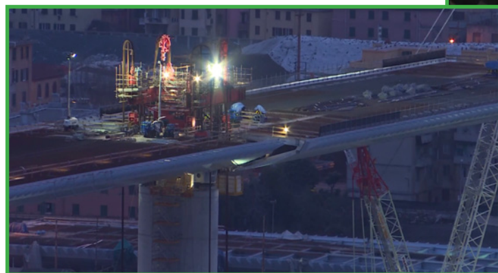
Tre momenti del sollevamento dell'impalcato sul torrente Polcevera, con la salita dalla base sopra il livello di via Trenta Giugno fino in cima alle Pile 9 e 10 nella notte del 10 marzo
