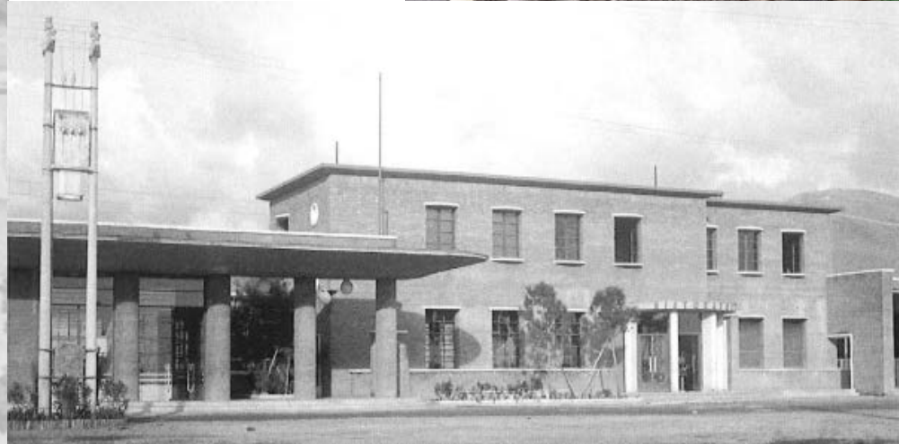
Fotografia. Vista del Fabbricato appena concluso.
