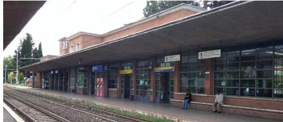
Fotografia. Vista del Fabbricato dalle banchine.
