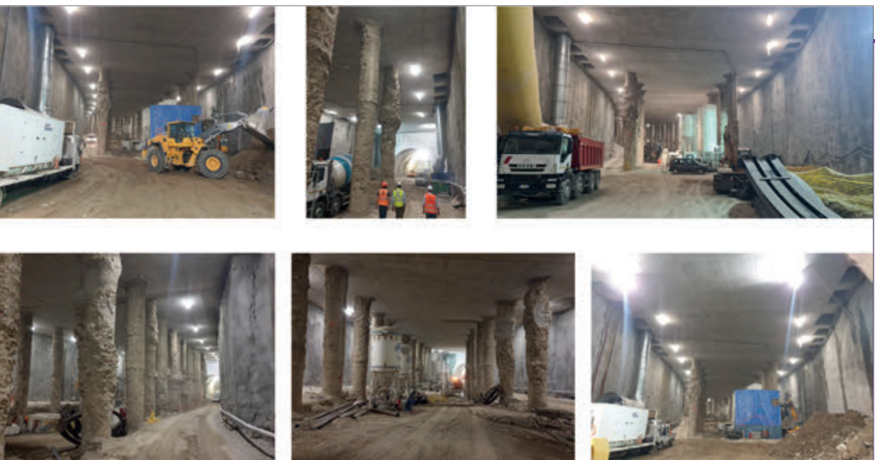
Fig 5 – Galleria Artificiale UDEC – Fotodocumentazione dei lavori in corso
