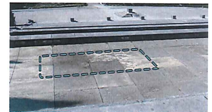
Pavimentazione delle gradonate in calcestruzzo
