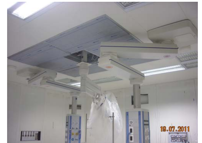
Una delle sale operatorie in fase di ultimazione
