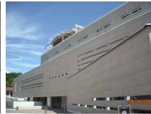
Il prospetto principale con l'ingresso
