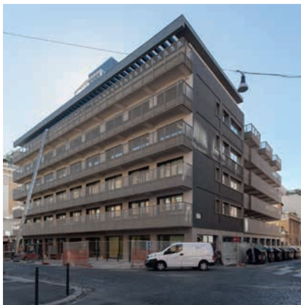
Restyling della facciata, space planning degli interni ed efficientamento energetico e idrico di una nuova sede distaccata di Cassa Depositi e Prestiti a Roma – Lombardini22
